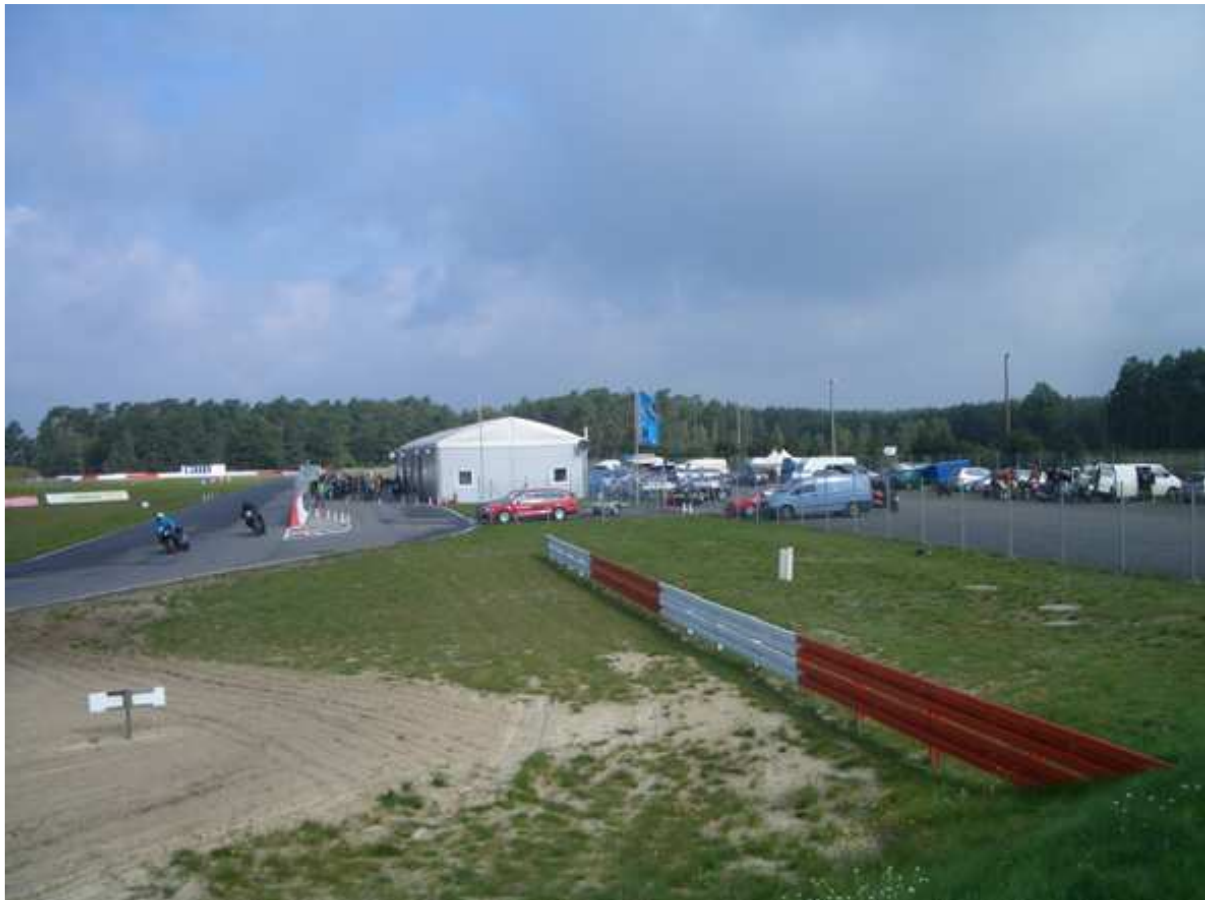
Ansicht vom Lärmschutzwall: Start-Ziel-Gerade, Boxengasse, Boxenhalle, Fahrerlager
